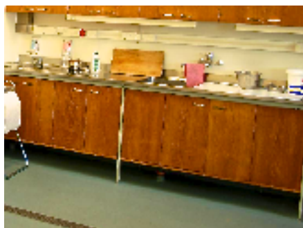
Handfat för handtvätt (till vänster) måste vara ett annat än vask och tapp för livsmedelsproduktion. Golvbrunnen är avlång med ett galler för att lätt få ner rengöringsvatten.
